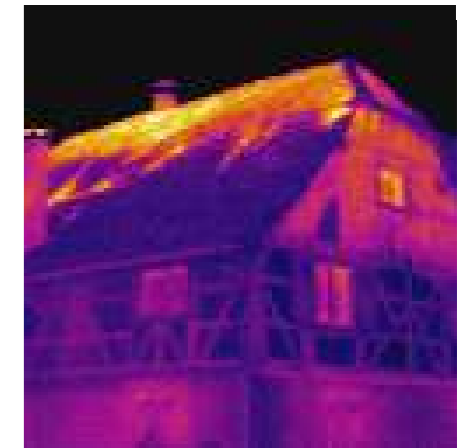
Mantenimiento de Edificio
